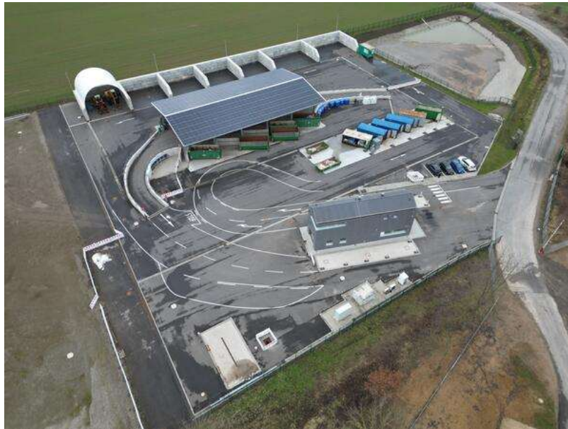
Abbildung 8: Luftbild Müllumschlagstation Bornhausen
