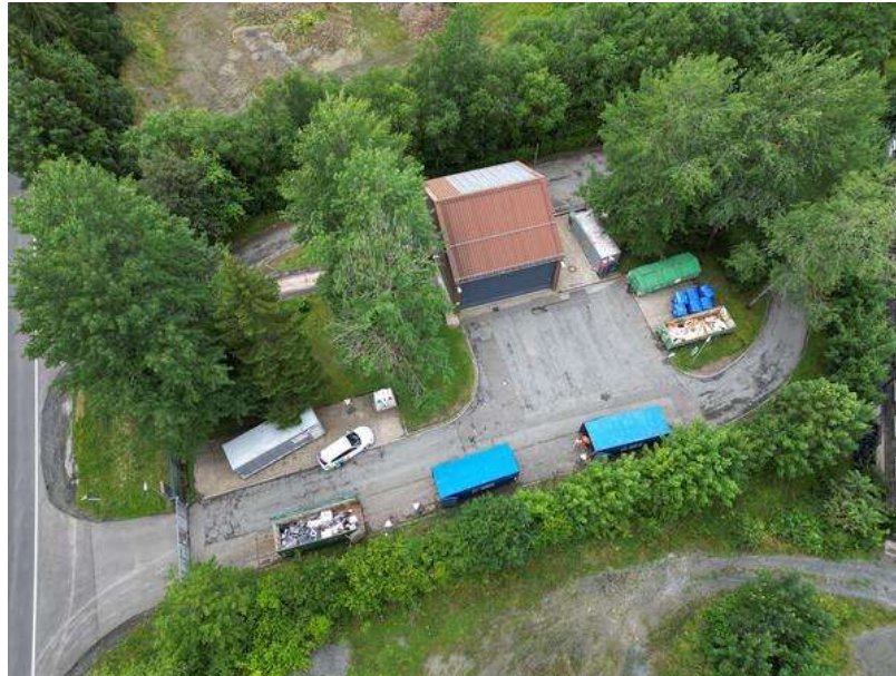
Abbildung 9: Luftbild Müllumschlagstation Clausthal-Zellerfeld
